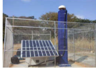
CORS स्टेशन सेटअप
